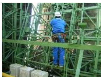
専門業者による点検作業②
