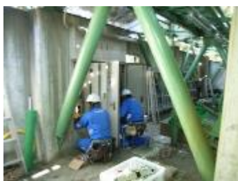
専門業者による点検作業①
